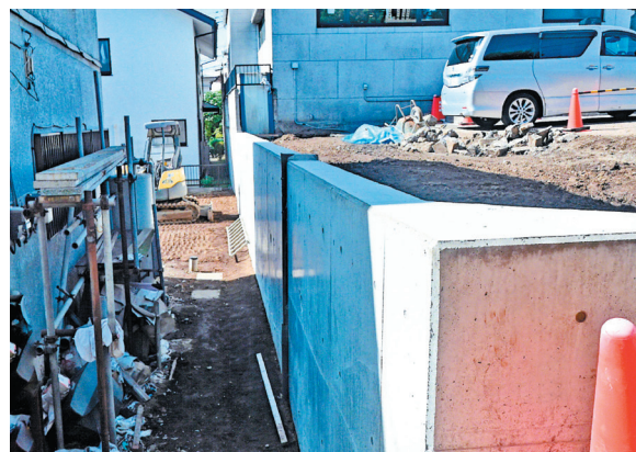
ほぼ完成した擁壁工事(2023.10撮影)
