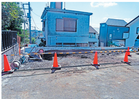
駐車場側(2023.10撮影:工事は未開始)
