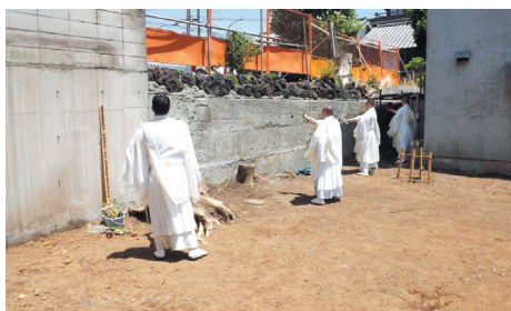
擁壁工事安全祈願
